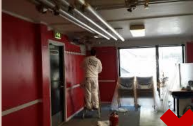
Reparation og vedligehold
